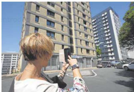
Vivienda familiar Naiara Zamarreño fotografía el edificio remozado donde vivían, en el número 6 de la calle Basanoaga, en el barrio de Capuchinos.
