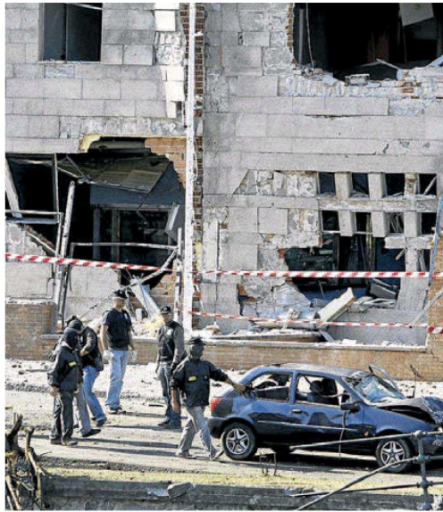
El atentado causó daños en cientos de viviendas y vehículos. :: EFE
