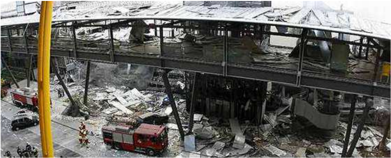
Estado en el que quedó el aparcamiento D de la terminal 4 del aeropuerto de Barajas tras la explosión de la bomba de ETA / CLAUDIO ÁLVAREZ
