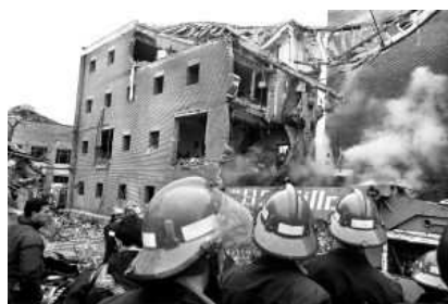
Unos bomberos, ante el cuartel de la Guardia Civil destruido por la explosión del artefacto / ANTONIO ESPEJO
